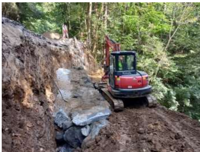
Sanacija plazu ob lokalni cesti Tinje – Planina
