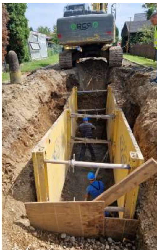
Izgradnja kanalizacije v Njivercah
