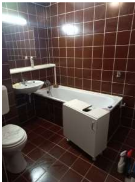
Primer obnove kopalnice pred izvedbo...
