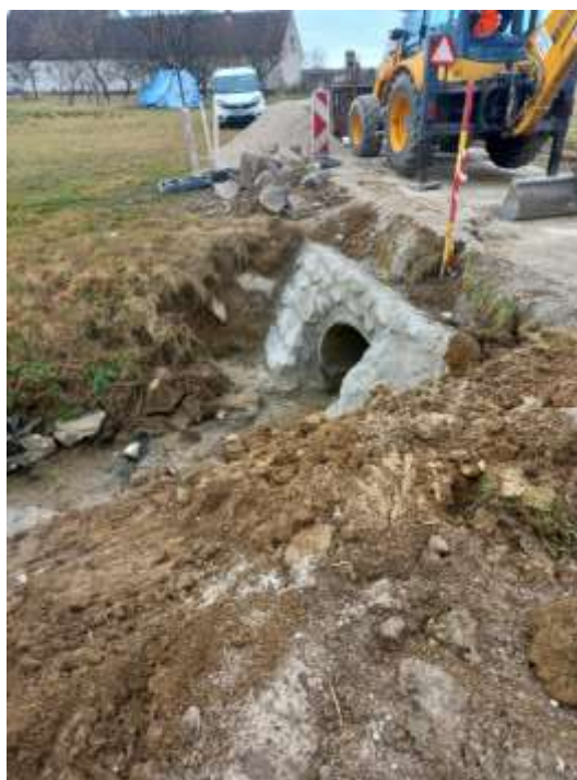
Sanacija prepusta na lokalni cesti v Zg.Polskavi
