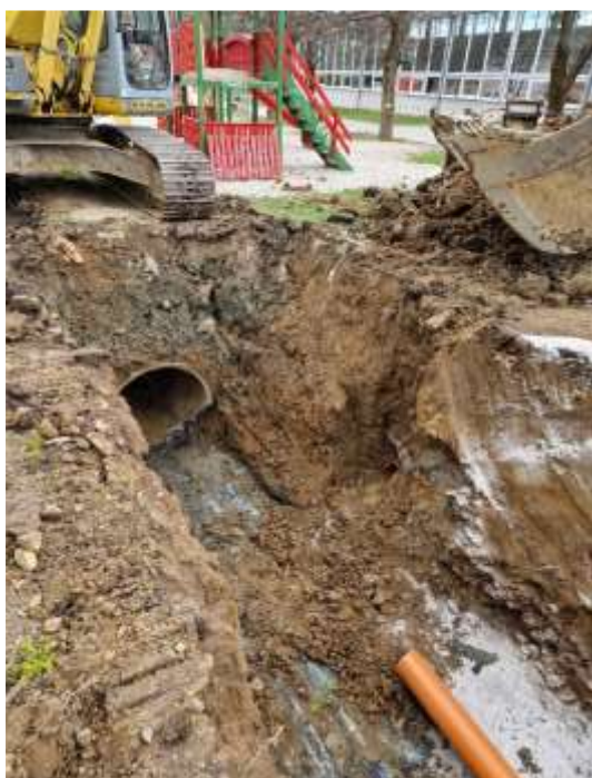
Sanacija obstoječe meteorne kanalizacije Prežihova ulica – Partizanska ulica
