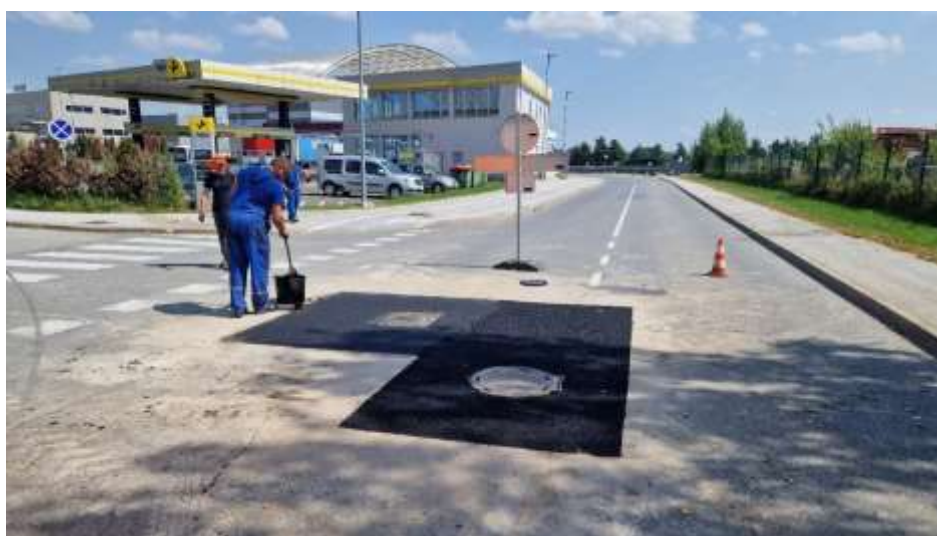
Sanacija kanalizacijskih pokrovov v Žolgarjevi ulici
