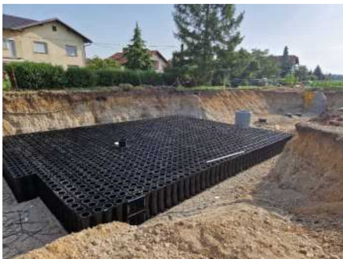
Rekonstrukcija ceste, vodovoda, fekalne in meteorne kanalizacije, Njiverce
