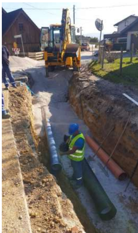
Izgradnja FK in MK ter vodovoda v Kajuhovi ulici
